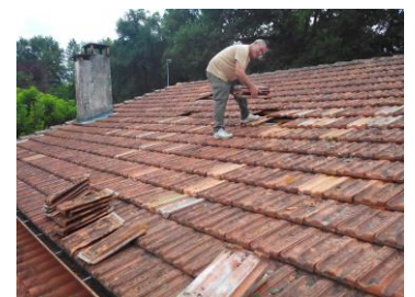
Changement des tuiles Bâtiments communaux
