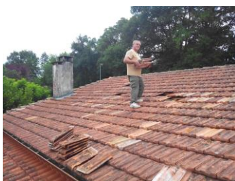
Remplacements des tuiles toiture salle polyvalente
